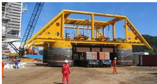
Płyta fundamentowa zainstalowana na złożu Vilje
